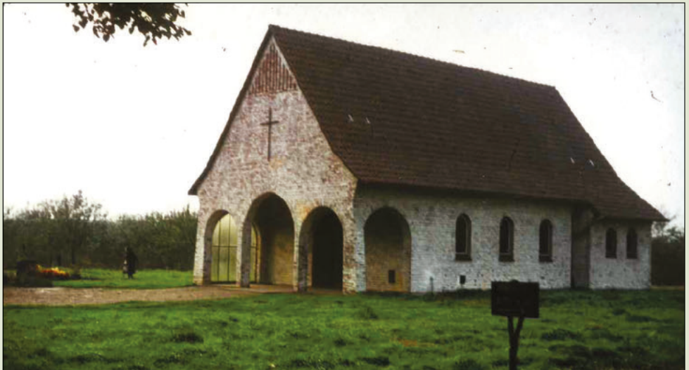
Die Friedhofskapelle vor dem Umbau
