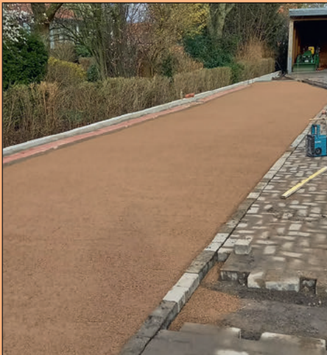
Die Auffahrt wurde neu geplastert
